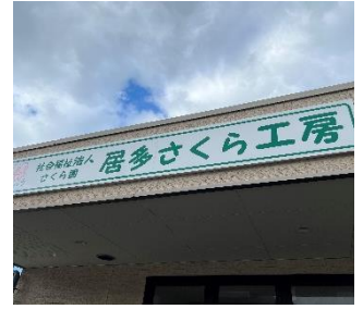
復旧後の看板
